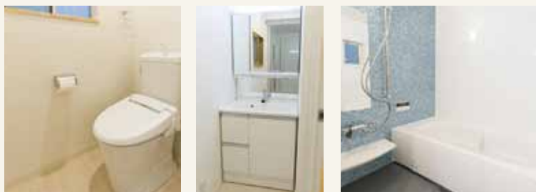
リクシル製節水トイレ、カウンター洗面ドレッサー、パナソニック製1616サイズシステムバス
